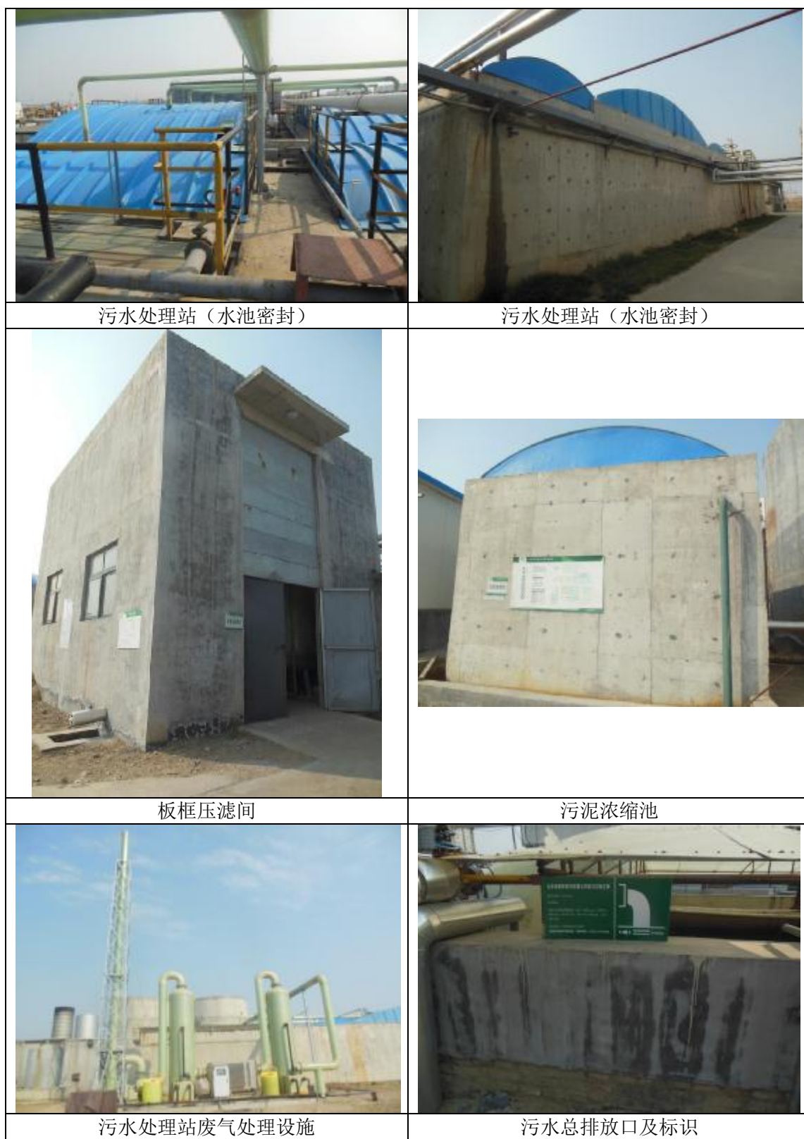
图 4.1-4 废水处理设施现场图片
